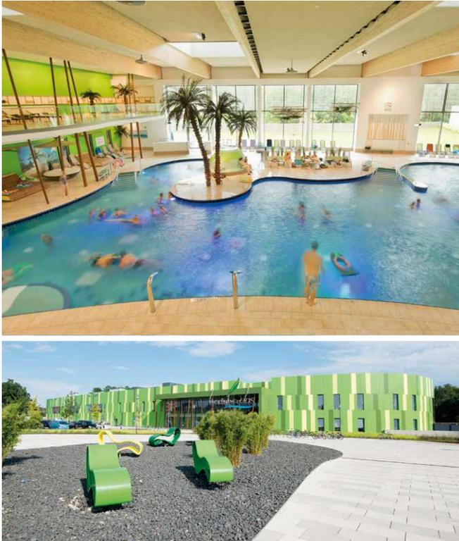
Das erste Passivhaus-Hallenbad in Europa – mit dem Bambados setzen die Stadtwerke Bamberg Maßstäbe. Es wird 56 Prozent weniger Wärme benötigt als bei herkömmlicher Bauweise. Möglich wird das durch die kompakte Bauform des Gebäudes mit einer luftdichten Gebäudehülle und eine sehr effiziente Gebäudetechnik, die zum Teil extra für das Bambados entwickelt wurde.
