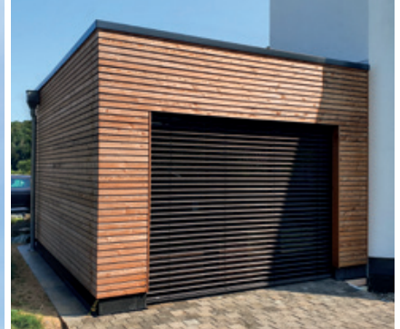
Anbau in Holzleichtbauweise
