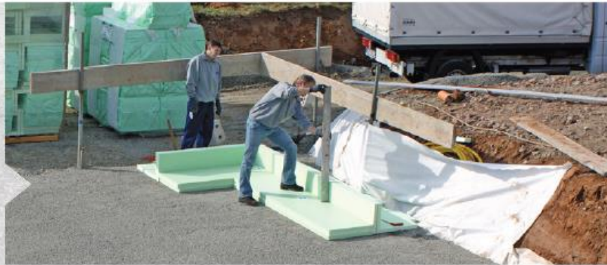
Verlegung der Rand- und Eckelemente
