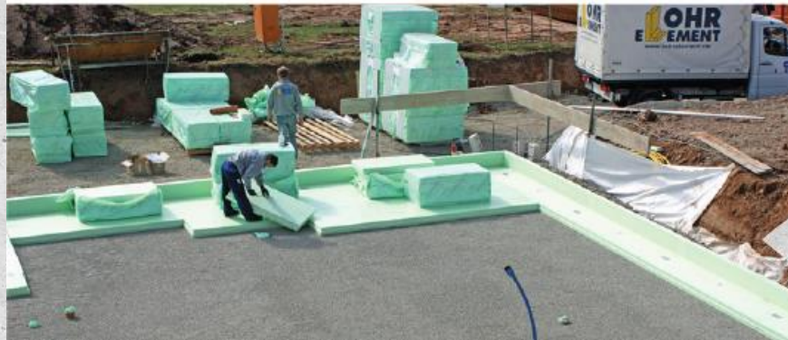
Verlegung der Flächenelemente, je nach Anforderung und Dämmstandard ein- bis dreilagig
